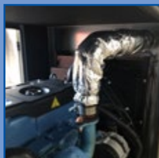
Выхлопные трубы с теплоизоляцией для эффективной и безопасной работы
